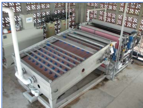
OMEGA 15 MD совмещенная с ленточным фильтр-прессом
